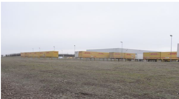
Abb. 1: Blick von Norden auf die Gewerbehallen
