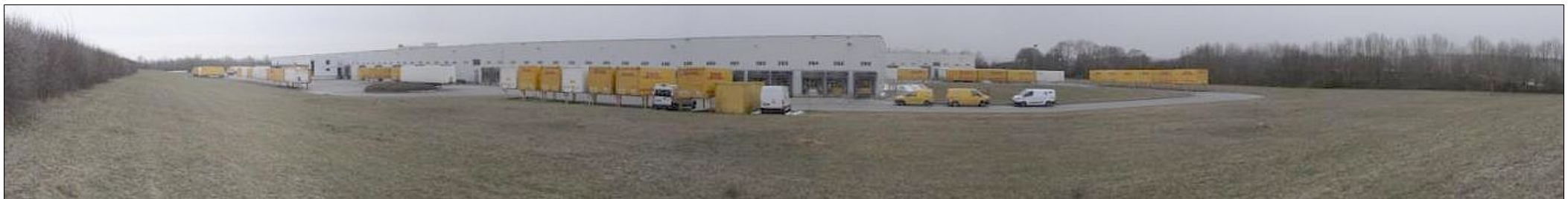
Ansicht auf das bestehende Postfachzentrum
